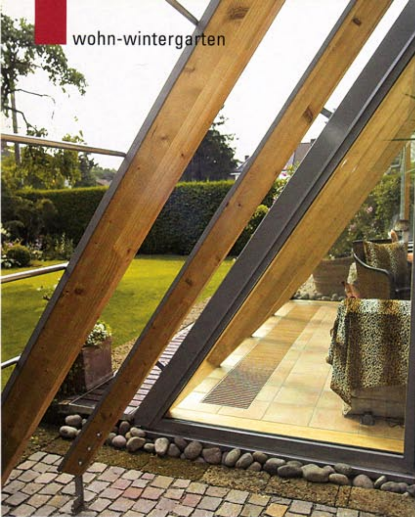
Gelungene Kombination: Die Holzträger sind außen mit Aluminium abgedeckt.
