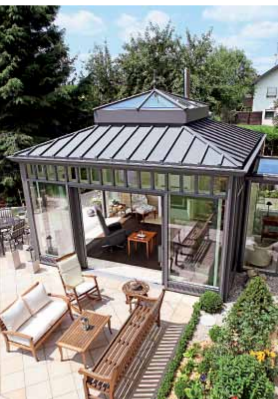
Sommers dient die großteils geschlossene Dachfläche als Sonnenschutz; bei tief stehender Sonne aber passieren die Strahlen die transparenten Fassaden.
