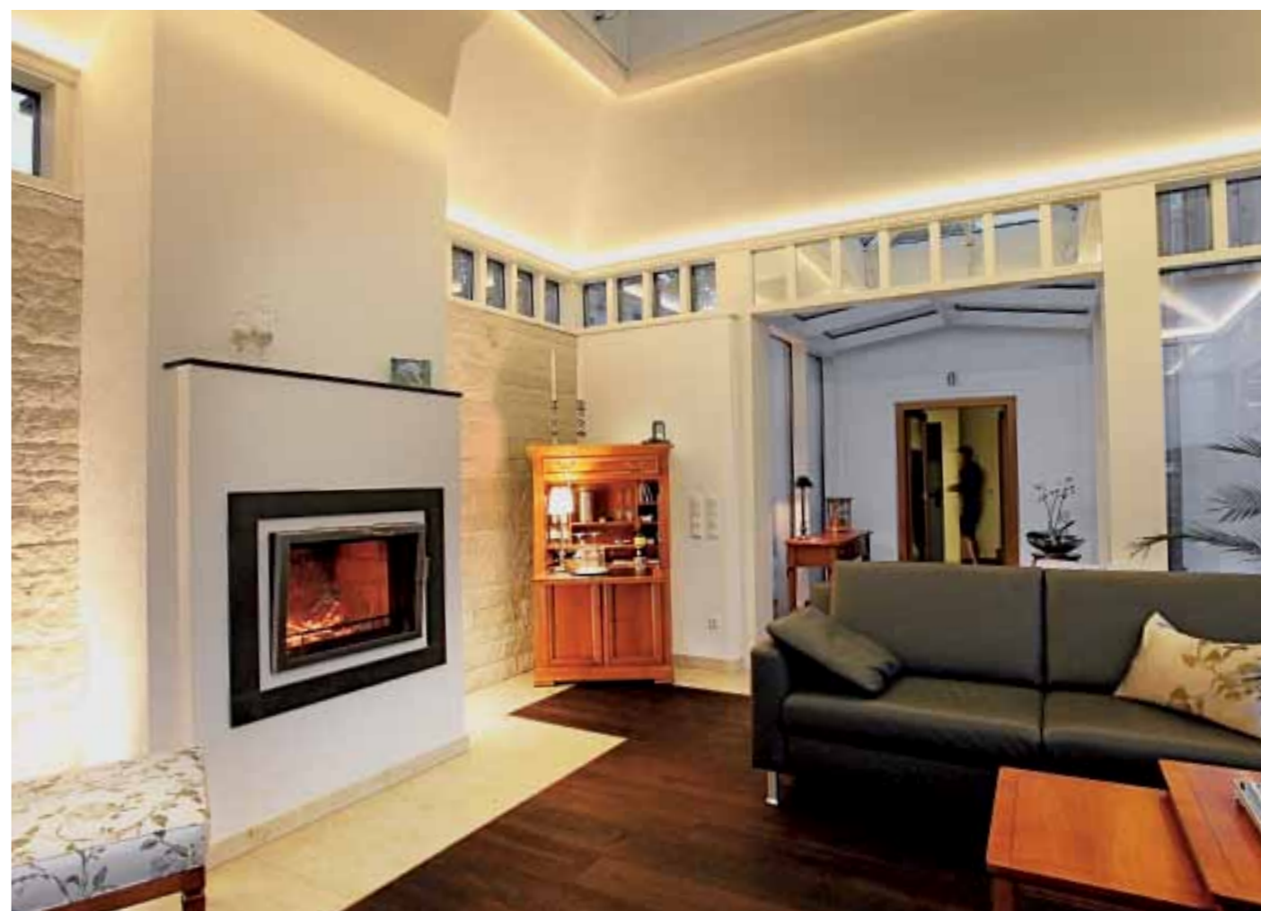
Brennraum und verwinkelte Rauchgaszüge sind gemauert. Etwa eine Stunde lodert das Feuer bei geöffneter Glastür, dann hält die Glut noch bis zu 12 Stunden.
