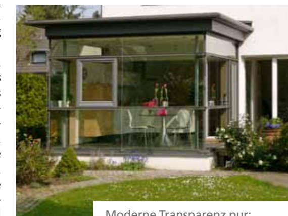
Moderne Transparenz pur: Dank Ganzglasrahmenecke scheint das Dach zu schweben.
