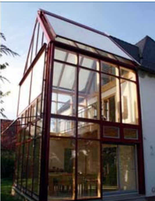
Die Dachbeschattung und der Fassadensonnenschutz werden über Sensoren gesteuert
