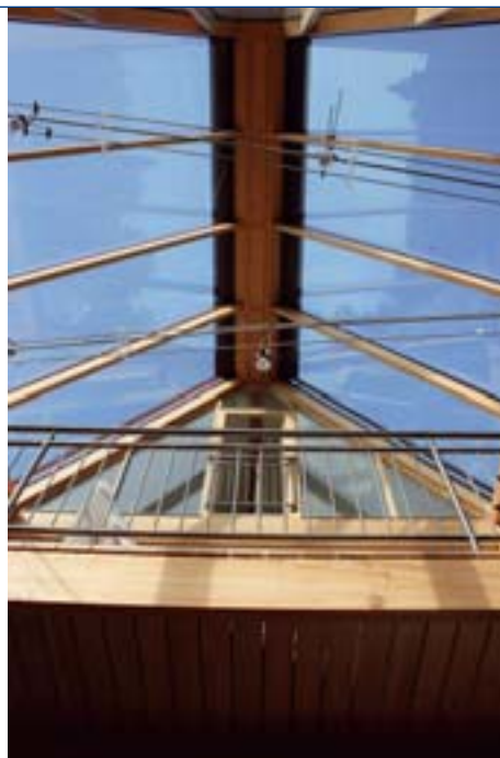
Aus gestalterischen und praktischen Gründen werden oft die Wintergärten in Holz-Alu ausgeführt
