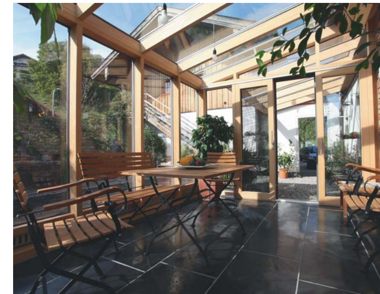
Als Gegenstück zur massiven Bauweise des Wohnhauses sollte der Wintergarten sehr filigran wirken. Deshalb wurde die Pfosten-Riegel-Bauweise gewählt
